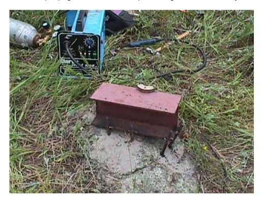
El trozo de viga ha sido soldado a las cabillas. Lo normal es fabricar una base plana y nivelada. En la montaña esto no es posible. Para subir la torre no dispondremos sino de un solo cable para subir y bajar la torre. Esa base debe ser muy resistente. En un sitio plano las cosas cambiarían.
