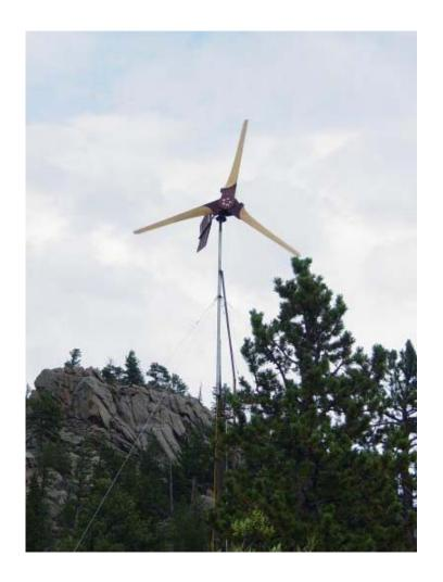
El que sigue es un diario de cómo construimos nuestras últimas cinco turbinas de viento que son casi idénticas. El molino consiste en un alternador de dos rotores de campos axiales, con veleta oscilante y una hélice de tres aspas de 10 pies de diámetro. Se inspira en el último diseño de Hugh Pigott. Haga clic aquí para visitar ese sitio y obtener amplia información en inglés.
