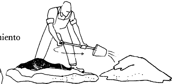
Worker mixing cement and sand Operario mezclando el cemento y arena
